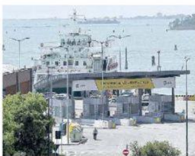
TRONCETTO L'area di imbarco e sbarco dei ferry boat
